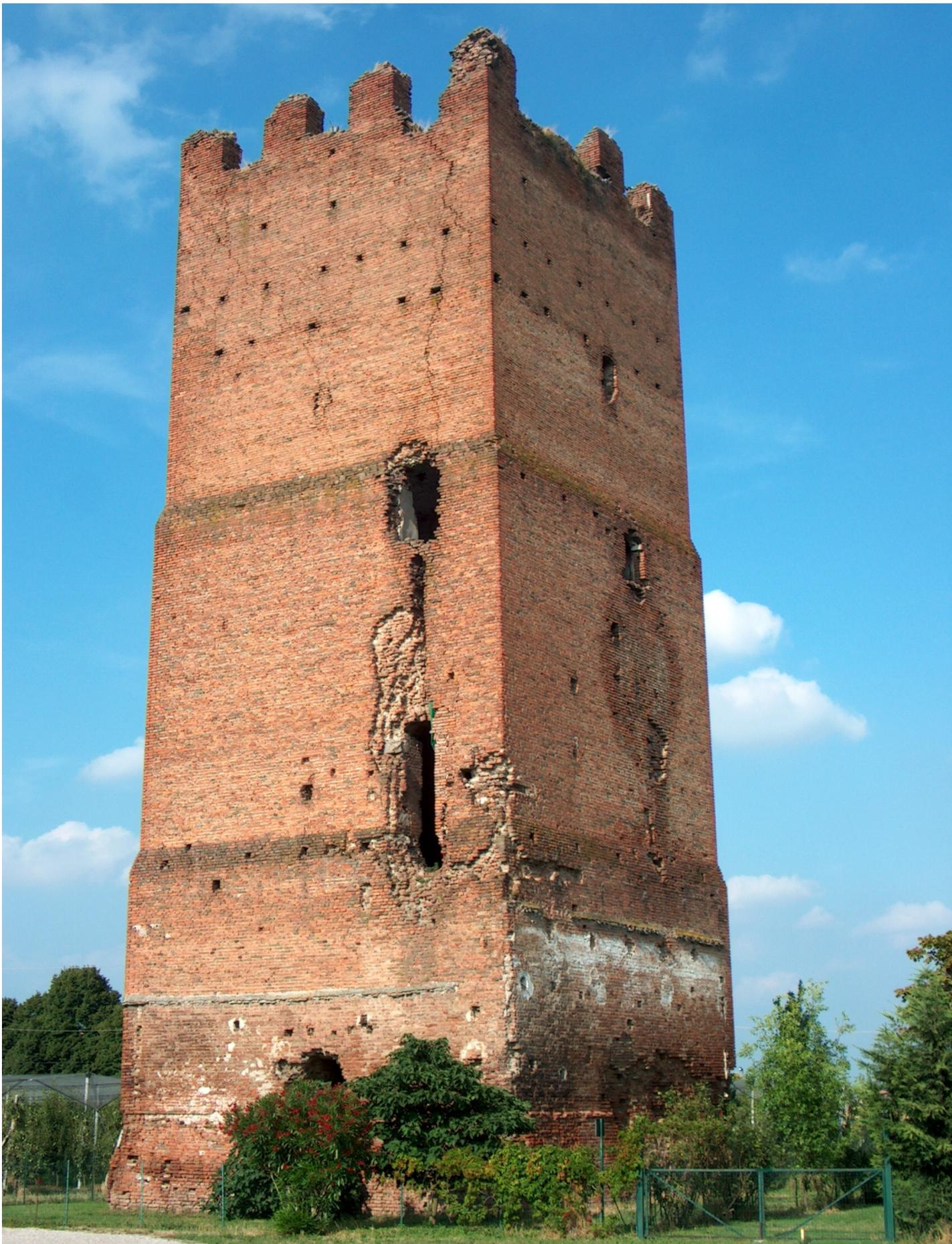
*La base trapeziodale della torre (scarpa) è interrata circa m. 1,20 per i detriti delle alluvioni che hanno alzato il piano di campagna. Alla fine della macchia di umidità sotto la finestra a Meridione vi è una fenditura (ora chiusa). Era una feritoia per arco in linea con la piattaforma del balestrone che vi era nell'angolo Sud-Est delle mura: da difendere con la vita, imponeva la legge.*
