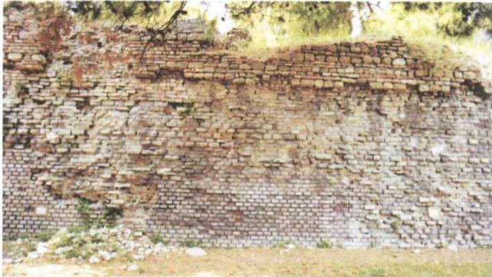
L'intervento ha previsto lo smontaggio puntuale di singoli elementi (circa 3 per mq), successivamente fasciati con tessuto di fibra di carbonio e connessi a due barre in vetroresina e infine ricollocati in sito, come diaconi, migliorando il raccordo con il nucleo interno.
